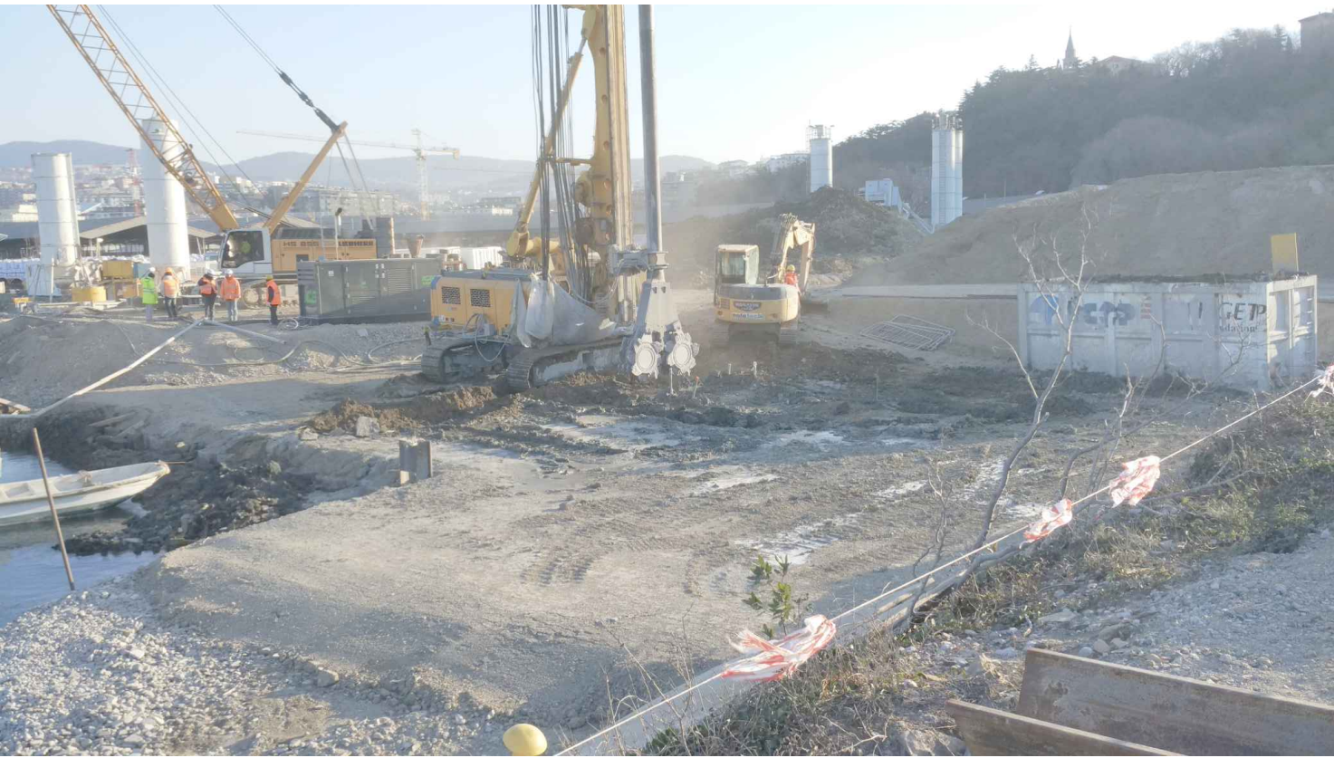
Esecuzione di diaframma plastico mediante l'utilizzo della tecnica CSM
