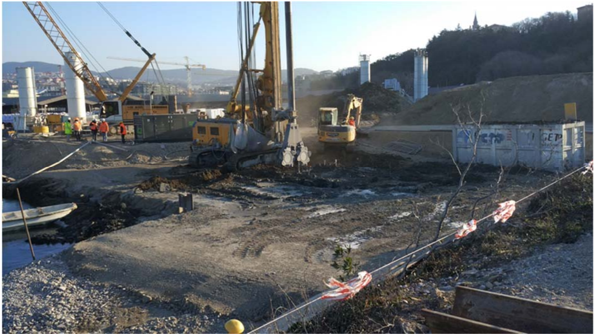
Figura 8. Esecuzione di diaframma plastico mediante l'utilizzo della tecnica CSM
