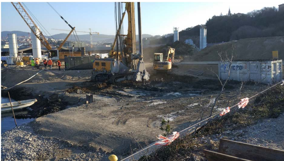
Figura 7. Esecuzione di diaframma plastico mediante l'utilizzo della tecnica CSM
