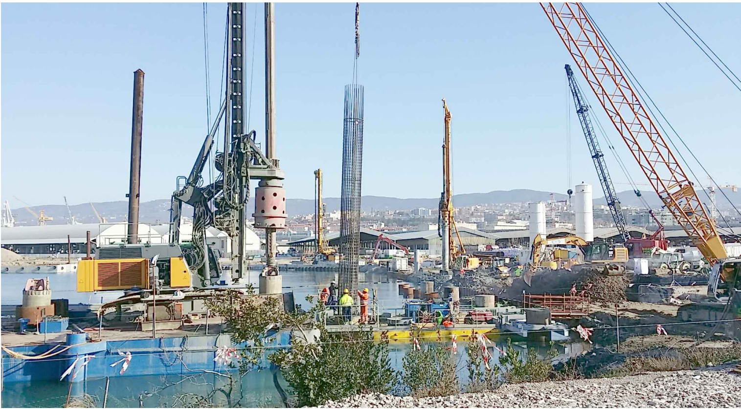
Esecuzione di pali trivellati Posa in opera di armatura metallica
