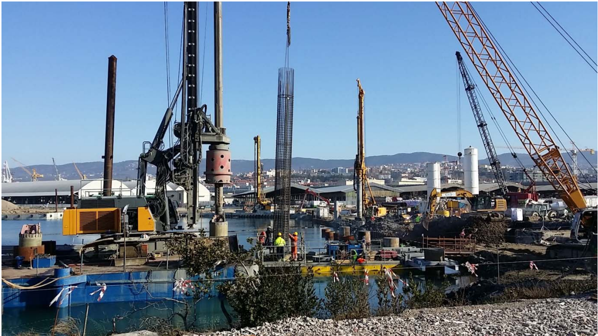
Figura 8. Esecuzione di pali trivellati – Posa in opera di armatura metallica
